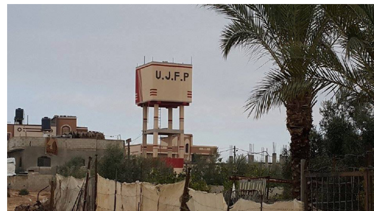
En finançant, en 2016, la construction d'un château d'eau à Khuza'a (village du sud-est de la Bande de Gaza), l'UJFP exprime sa frater- nité avec les paysans qui continuent à produire malgré le blocus et la répression israélienne.
